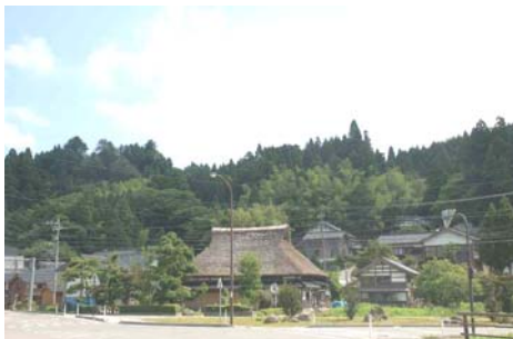
輪島市の入口に位置する茅葺き民家・旧福島邸
