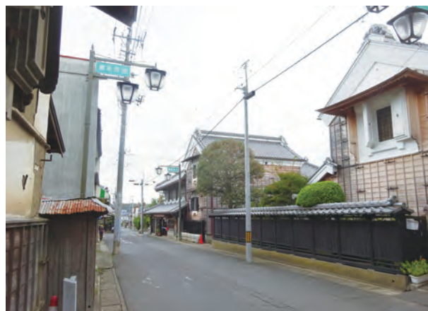
▲「復興した真壁の町並み」 桜川市
