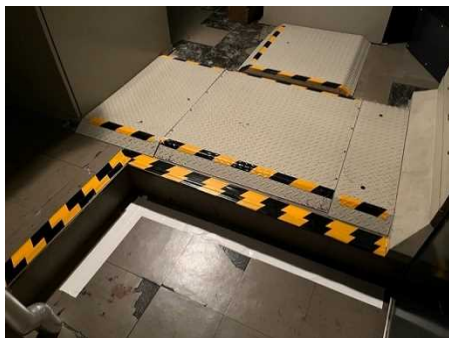
段差・突起物の注意標示
