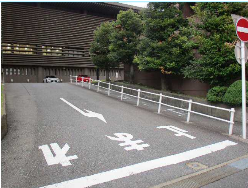
28 ガードパイプ
