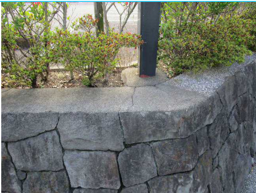
83 石積擁壁天端
