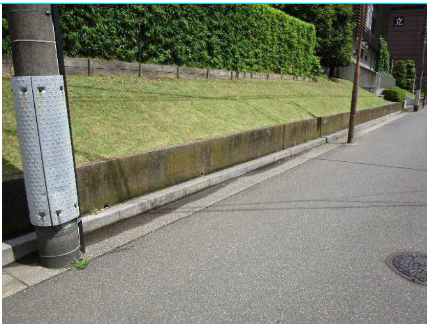
24 コンクリート土留
