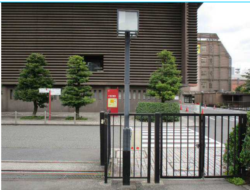
110 外灯B2 H=3.55m のぼり旗取付器具付き (のぼり旗無し) スチール製
