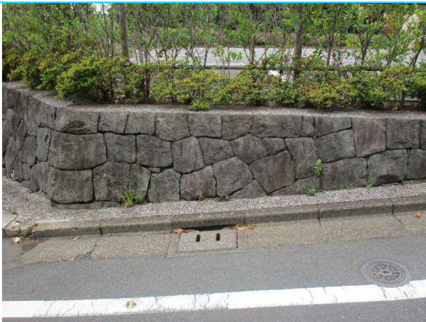
83 石積擁壁D面
