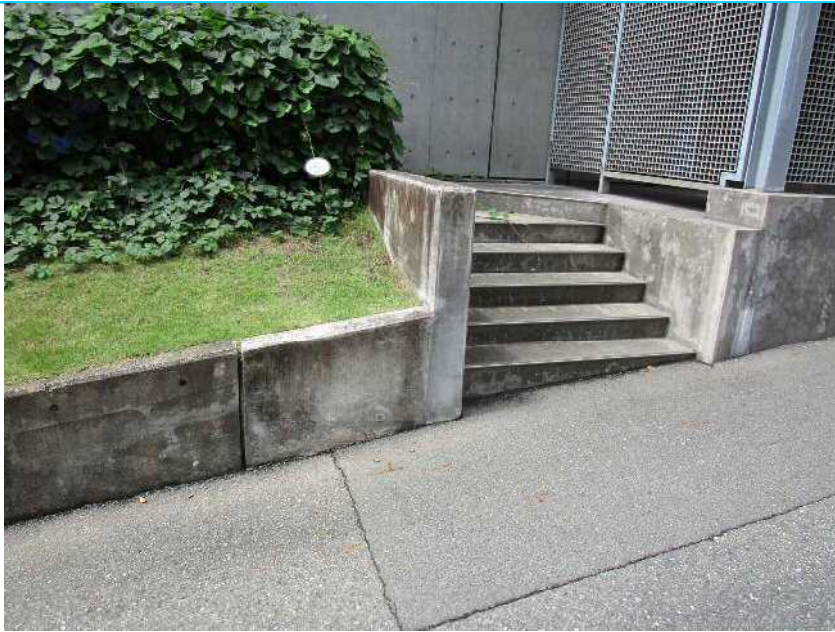
26 コンクリート土留
