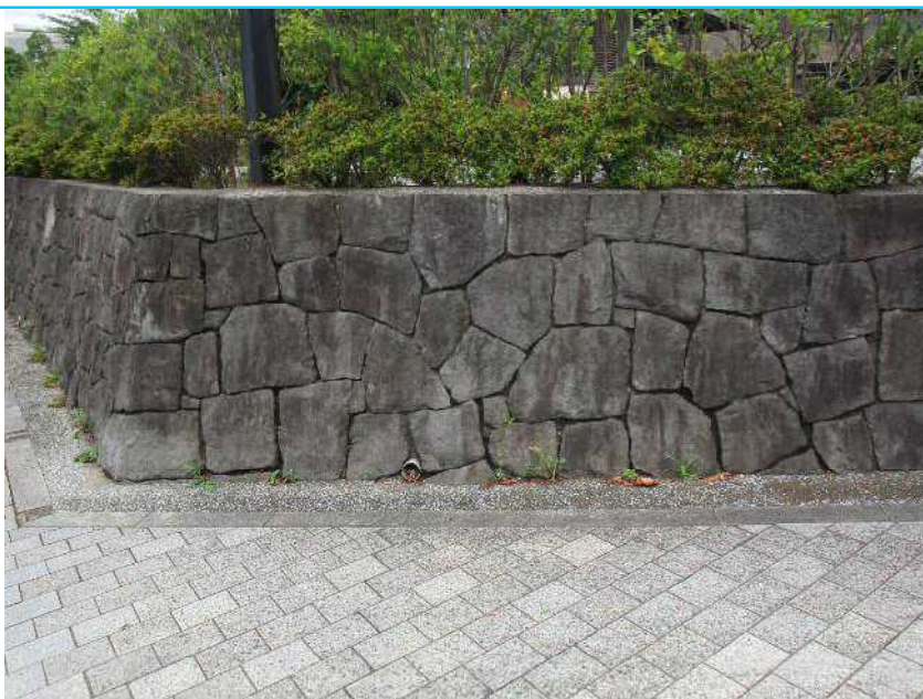
83 石積擁壁C面
