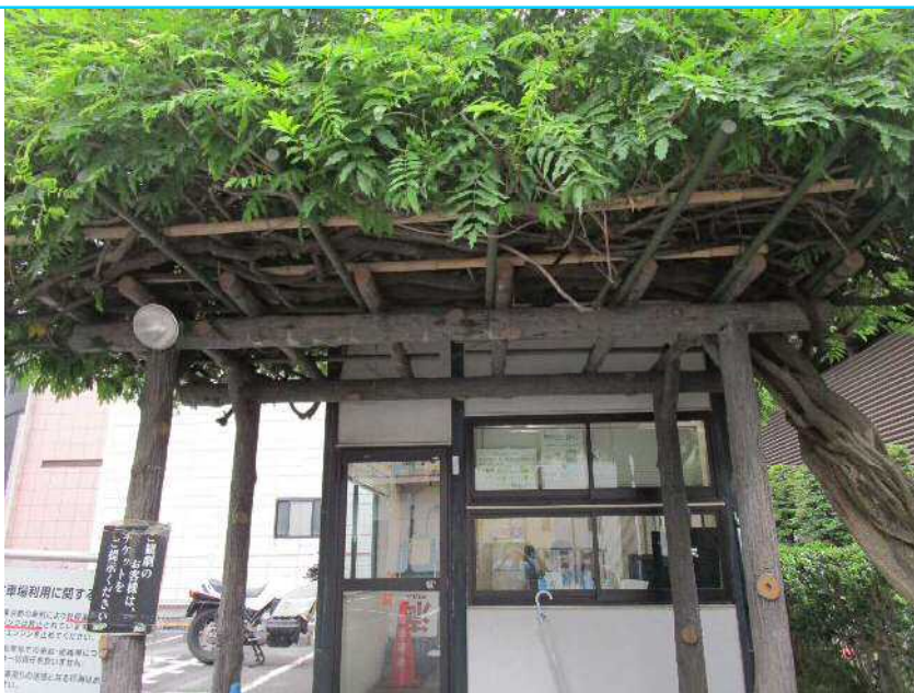
105 コンクリート製パーゴラ
