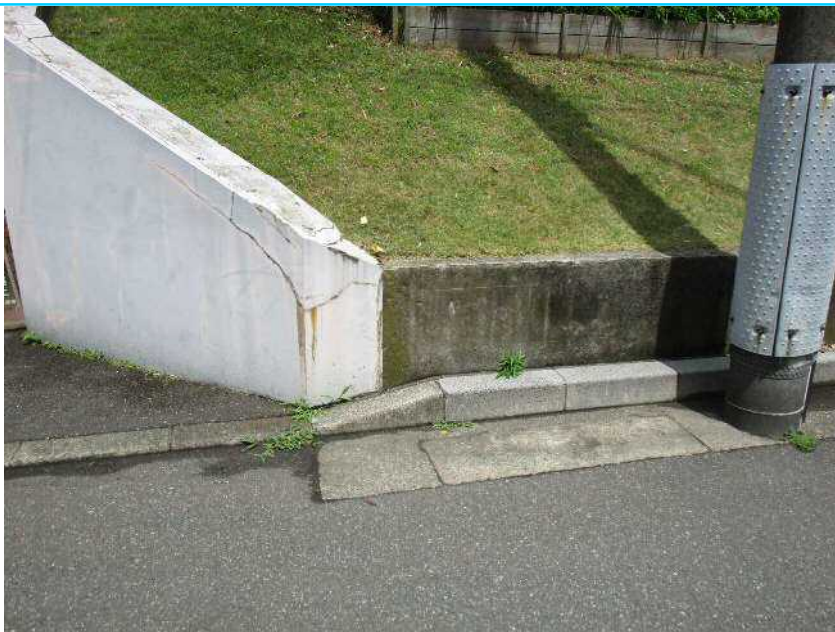
24 コンクリート土留
