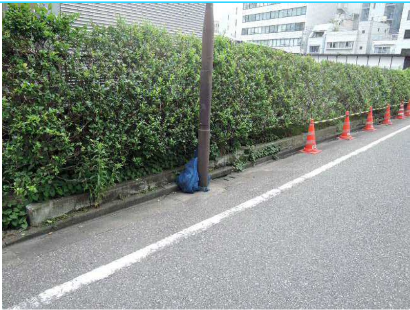
95 コンクリート土留
