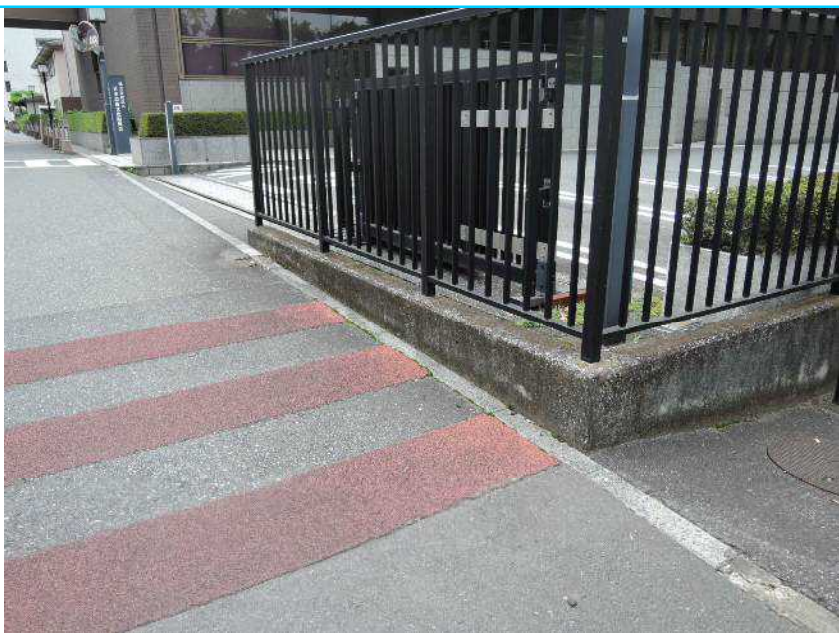
77 コンクリートフェンス基礎
