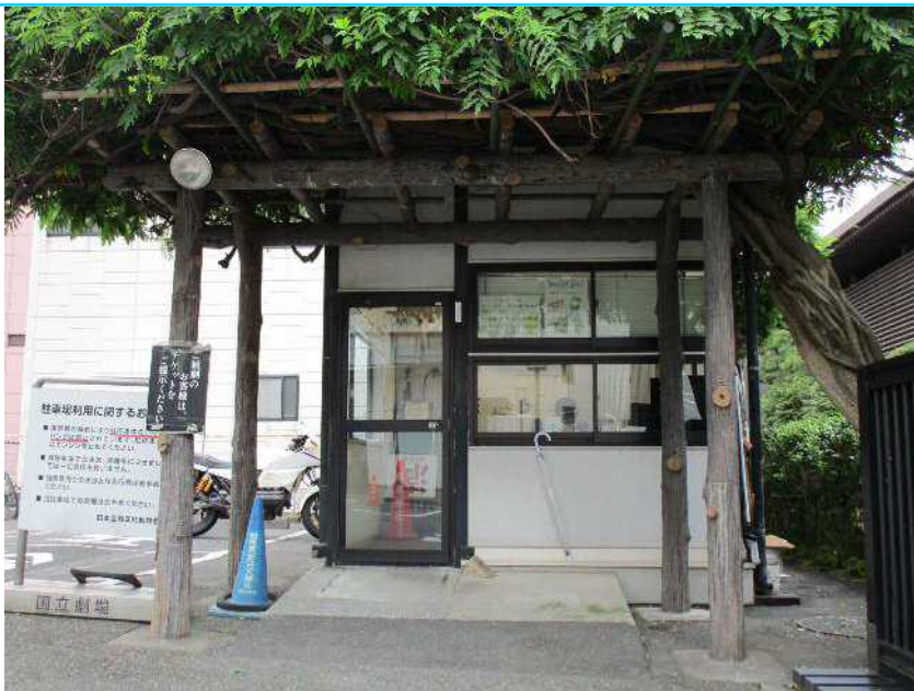
105 コンクリート製パーゴラ
