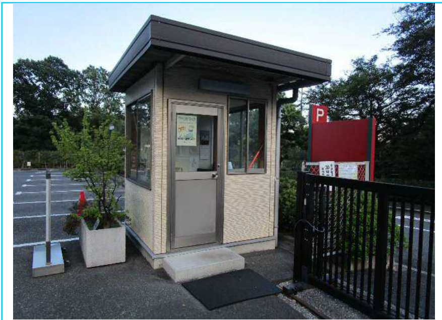
120 第一駐車場監視所
