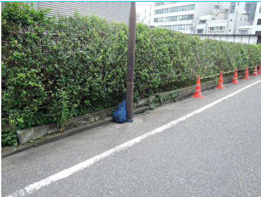
95 コンクリート土留
