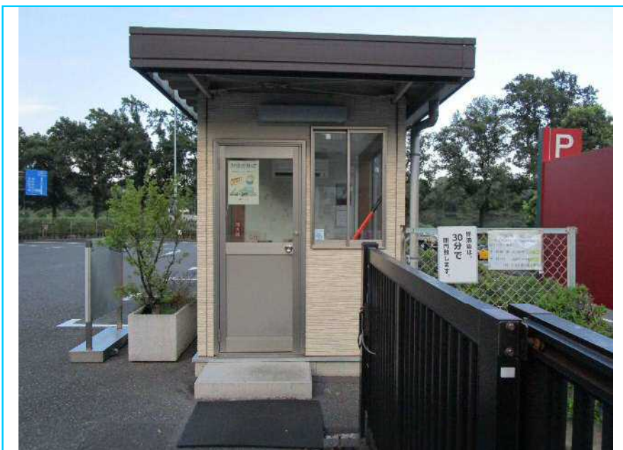
120 第一駐車場監視所
