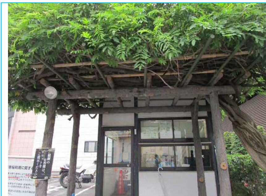
105 コンクリート製パーゴラ
