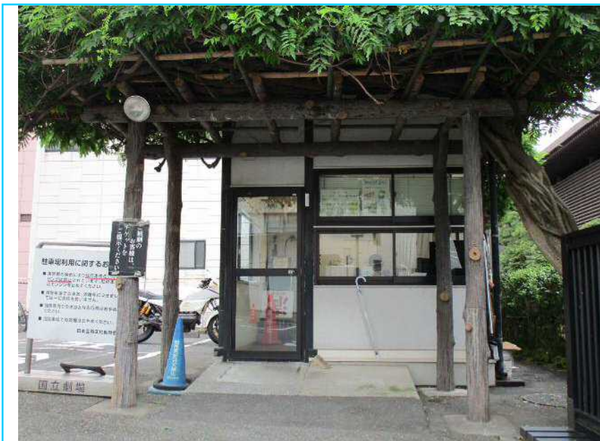
105 コンクリート製パーゴラ
