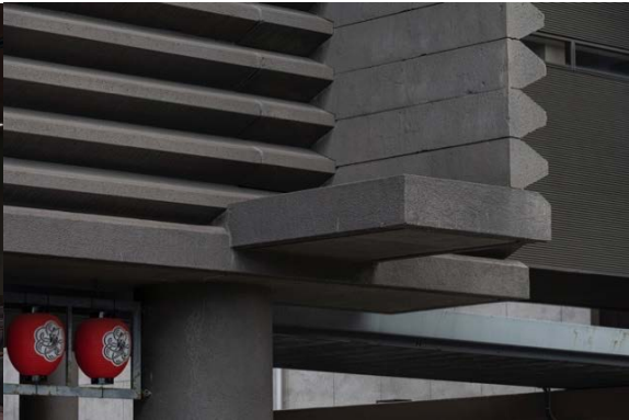
写真 7 国立劇場外壁ディテール
