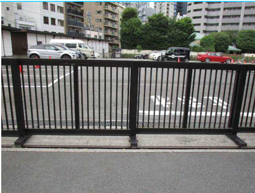
108 縦格子4枚引きアルミゲート H=1.40m W=8.15m ※立面図有り
