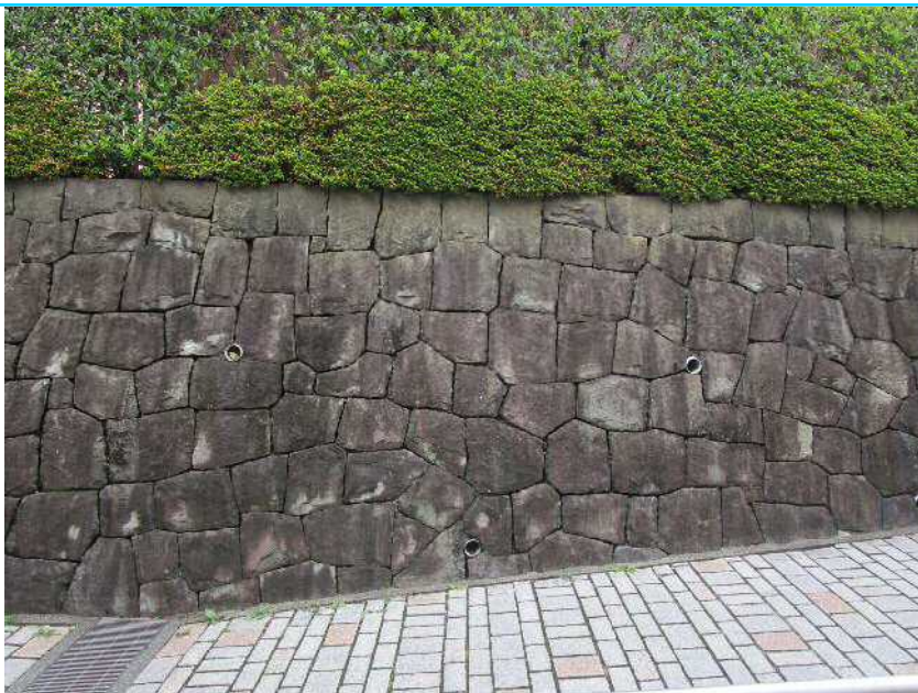
7 石積擁壁B面 H=2.30m～0.88m L=23.09m D=1.19m～0.74m ※立面図有り
