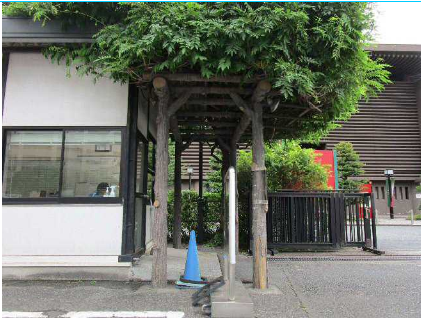
105 コンクリート製パーゴラ H=2.54m W=3.60m D=1.80m ※立面図有り
