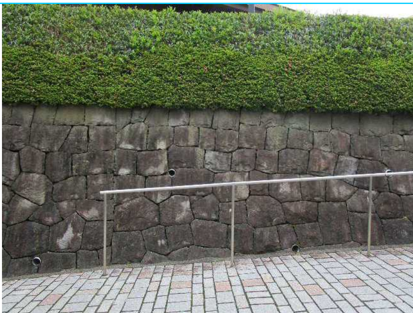
7 石積擁壁B面 H=2.30m～0.88m L=23.09m D=1.19m～0.74m ※立面図有り 8 手摺 H=0.88m L=24.82m 手摺・支柱直径0.035m アルミ製
