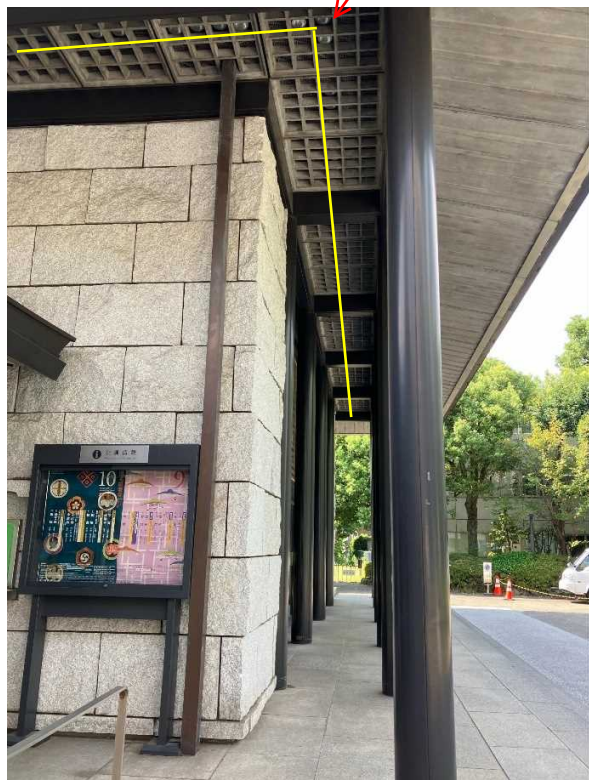
正面玄関 軒部分(CH5200)
