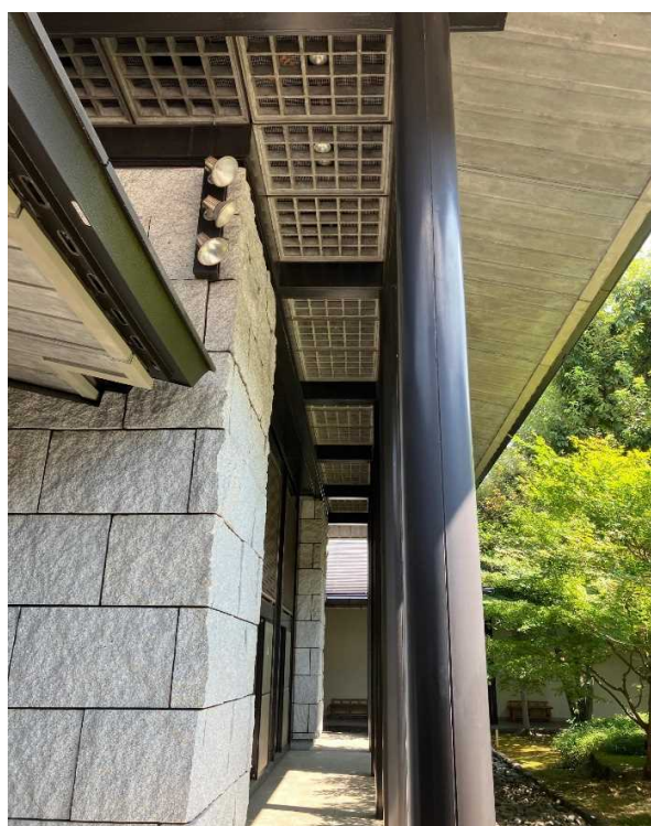
中庭 軒部分(CH5200)
