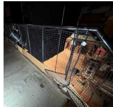
防火ネットと材木製の幅木
